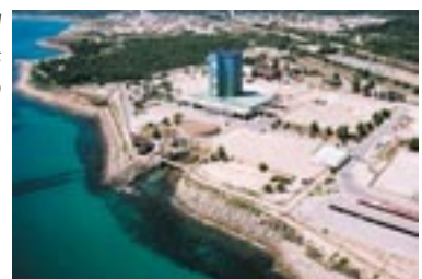
C. N. Vandellós I antes y después del desmantelamiento Nivel 2
