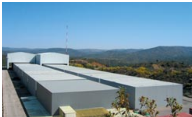
Plataforma de almacenamiento
